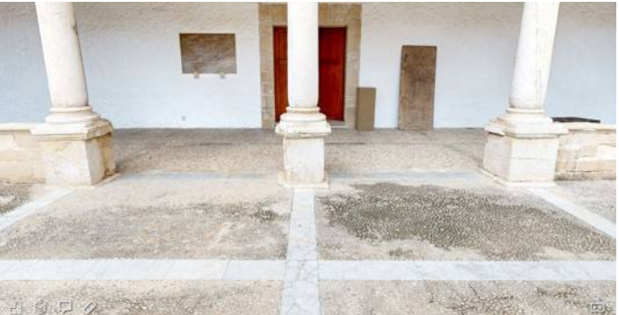
Paviments del pati del Claustre. Font: Geonord. Edició Arquitectura Genís Planelles, 2024.
