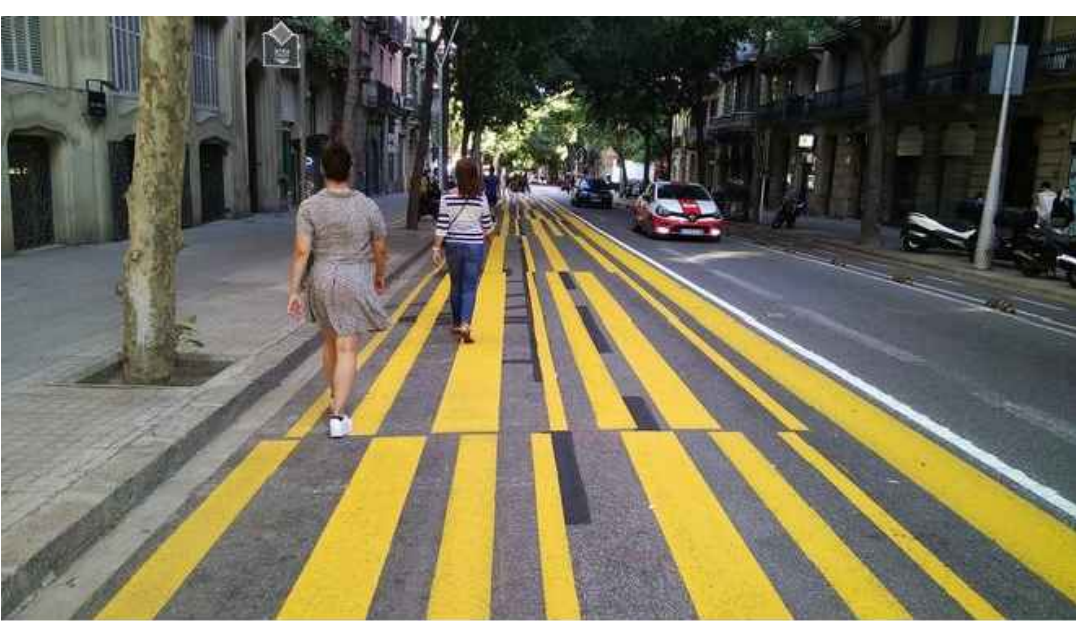
ejemplos de señalización horizontal sobre calzada mediante pintura plástica a base de resinas acrílicas, antideslizante, de acabado satinado y textura lisa para carriles peatonales, para salvar las discontinuidades existentes en las aceras
