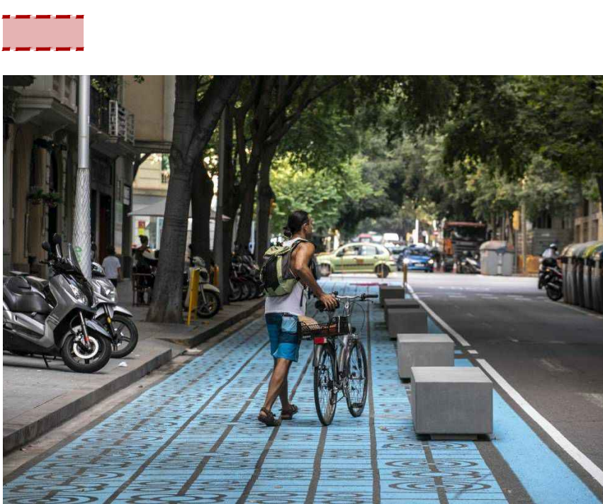
ejemplos de señalización horizontal sobre calzada mediante pintura plástica a base de resinas acrílicas, antideslizante, de acabado satinado y textura lisa para carriles peatonales, para salvar las discontinuidades existentes en las aceras
