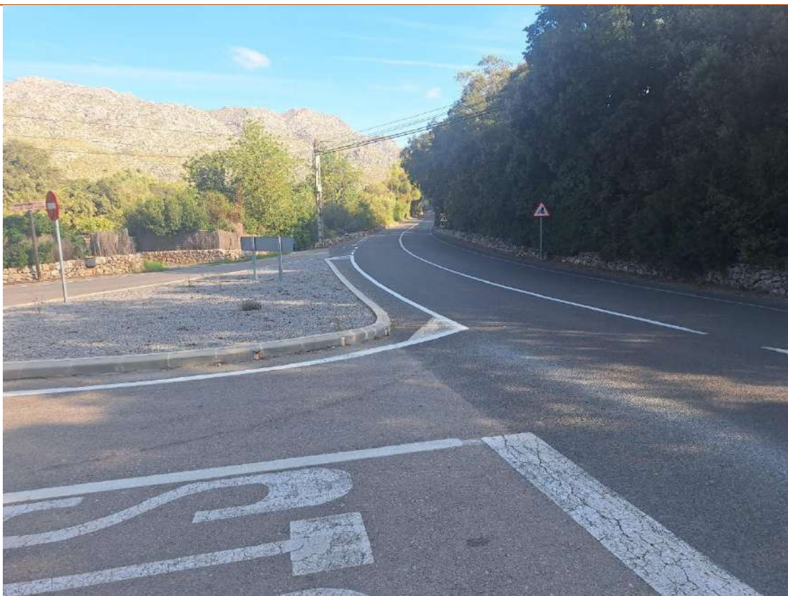
Imatge de la carretera MA 2203 amb encreuament del camí Vell de Sant Vicenç
