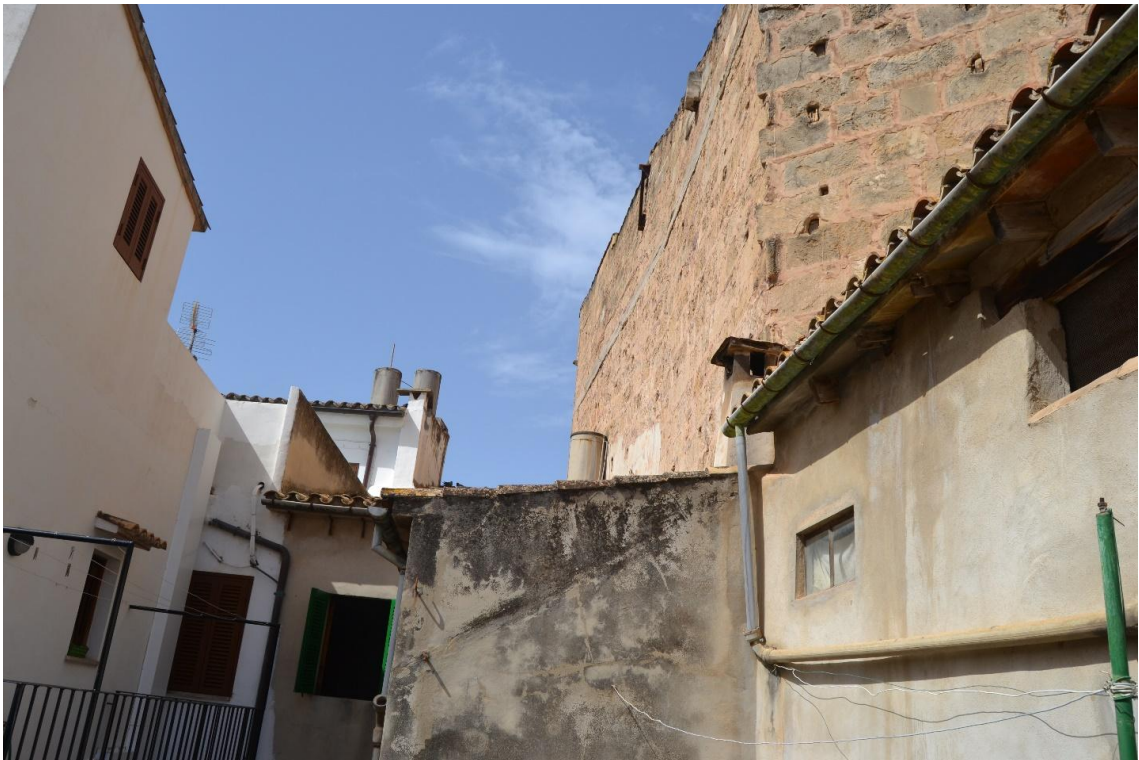
Interior vivienda colindante. Patio
