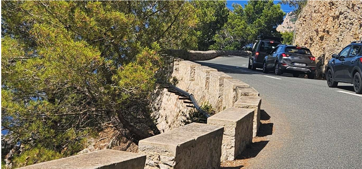
Canonada d'abastament d'aigua al seu pas per la carretera Ma-2210.
