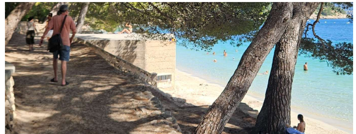
Punt de descàrrega d'aigües pluvials.
