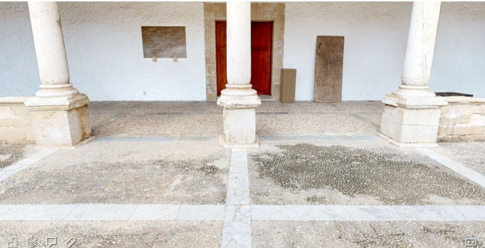
Paviments del pati del Claustre. Font: Geonord. Edició Arquitectura Genís Planelles, 2024.
