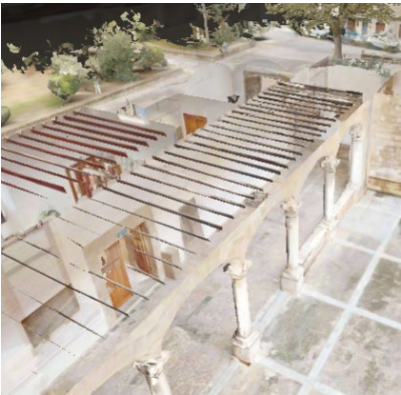
Vista de fotogrametria de l'estructura de la planta baixa del Convent. Font: Geonord. Edició Arquitectura Genís Planelles, 2024.
