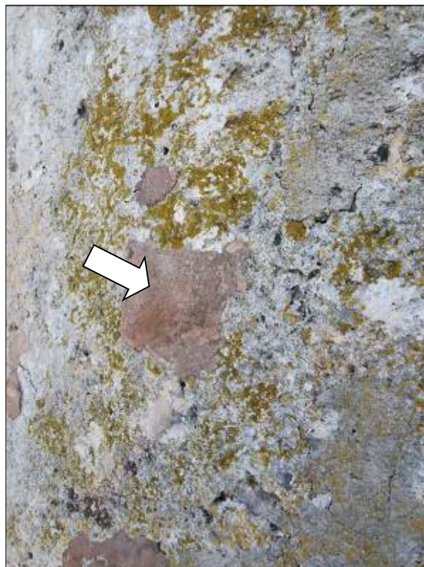
Reparacions realitzades amb morter de ciment natural que afecten puntualment a tota la superfície exterior de la torre
