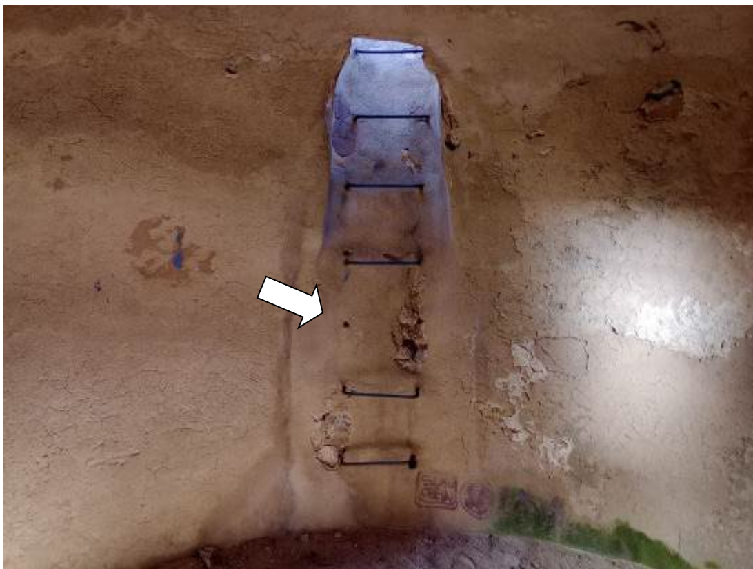
Barrots de ferro formant l'escala d'accés a coberta
