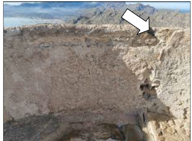
Pèrdues de volum que afecten també al paredat a la part superior de la torre.
