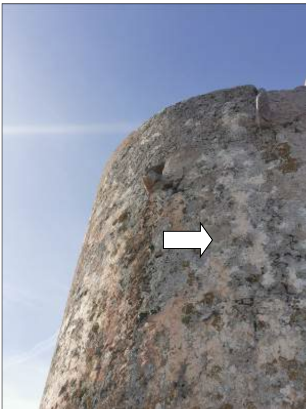
Reparacions realitzades amb morter de ciment natural que afecten puntualment a tota la superfície exterior de la torre
