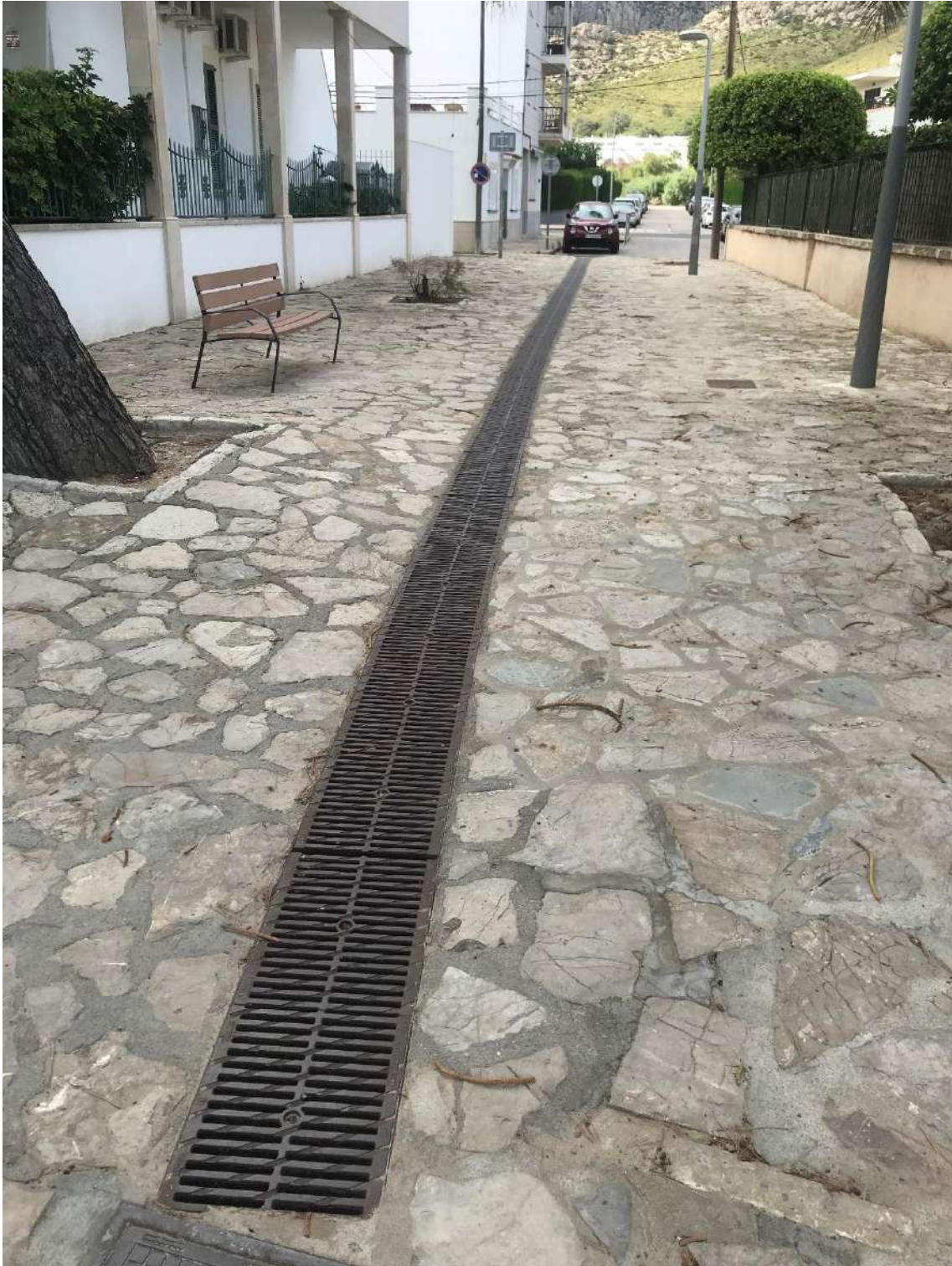
Imatge 27. Tram del C/Gregal immediat a la mar amb alta concentració de burilles i sense papereres.
