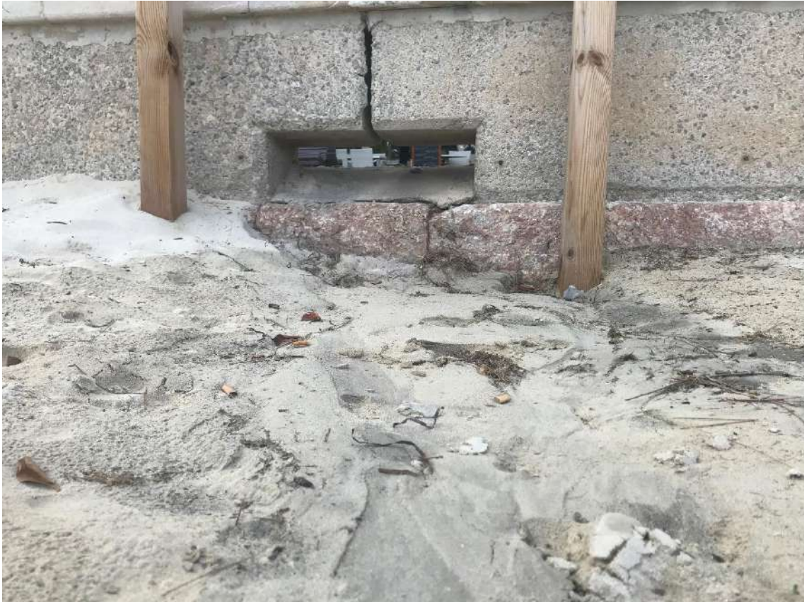
Imatge 17. Abocador d'aigua de pluja a una platja d'Albercutx amb burilles incrustades a l'arena.
