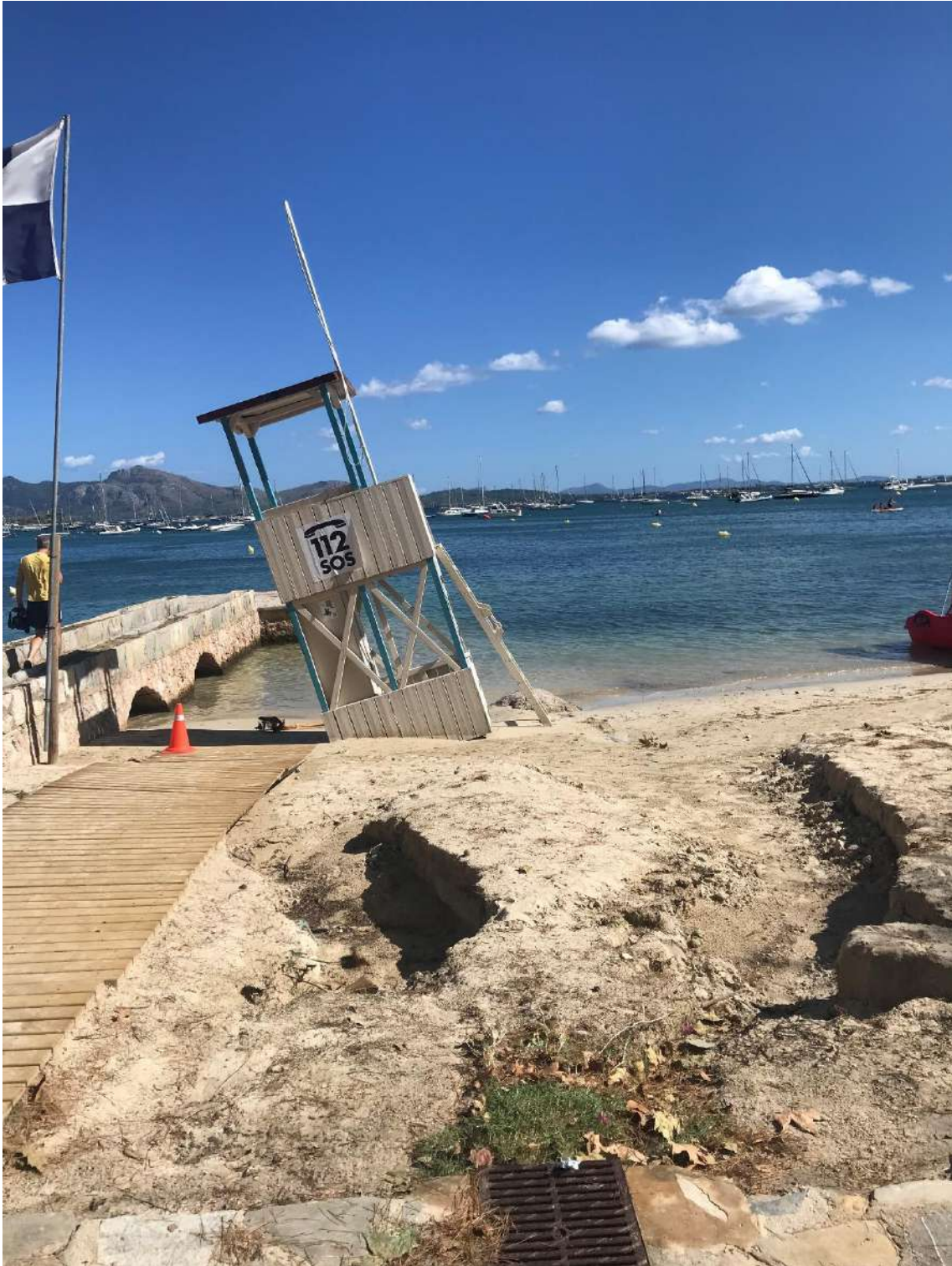
Imatge 10. Torre de vigilància dels socorristes d'Albercutx després de fortes plogudes (setembre 2023).
