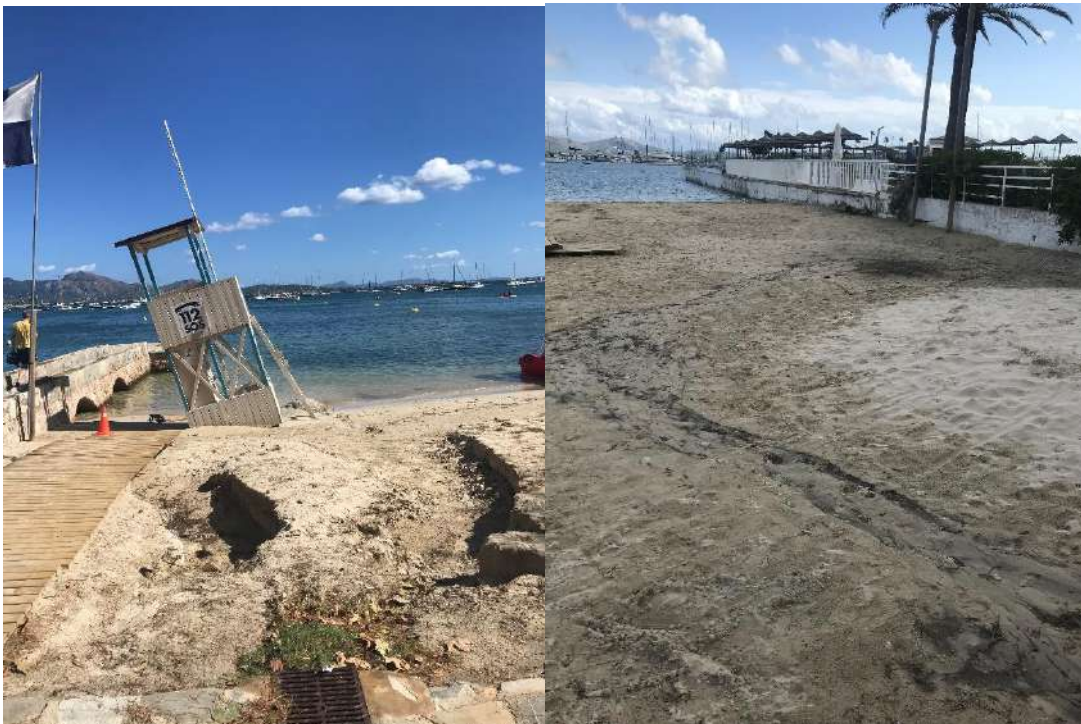
Imatge 4. Efectes de l'aigua el dia després de fortes pluges.
